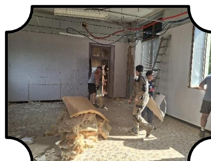
Démolition salle Association
